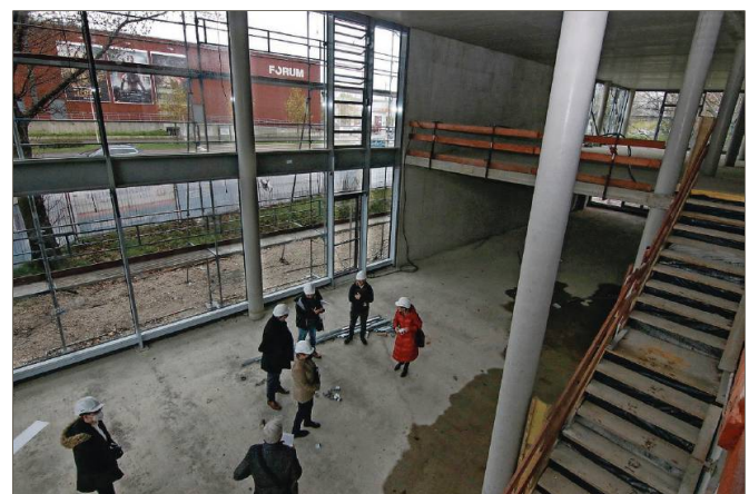
Baustellenrundgang mit Ministerin Nicole Razavi: Gegenüber dem Kino am nördlichen Stadteingang Rastatts entsteht der neue Gebäudekomplex. Foto: Frank Vetter
