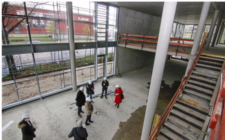
Baustellenrundgang mit Ministerin Nicole Razavi: Gegenüber dem Kino am nördlichen Stadteingang Rastatts entsteht der neue Gebäudekomplex. Foto: Frank Vetter
