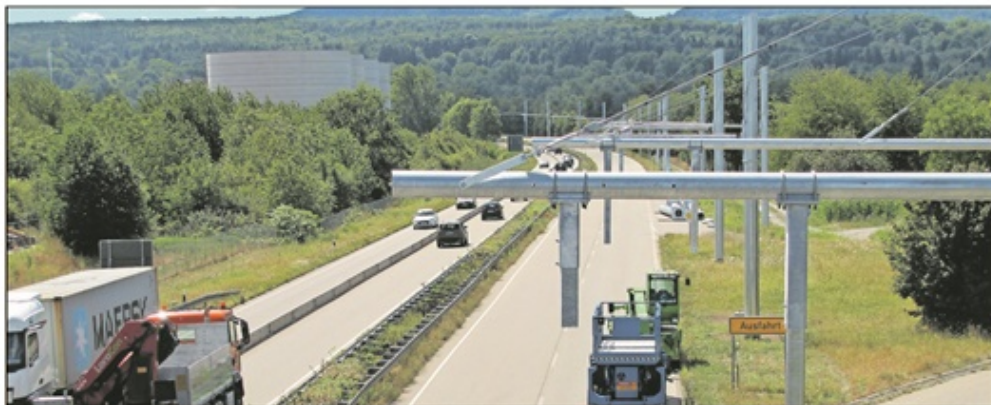
In Höhe von Bischweier sind an der Bundesstraße 462 in Fahrtrichtung Gaggenau die ersten Masten für die Oberleitung errichtet worden.
